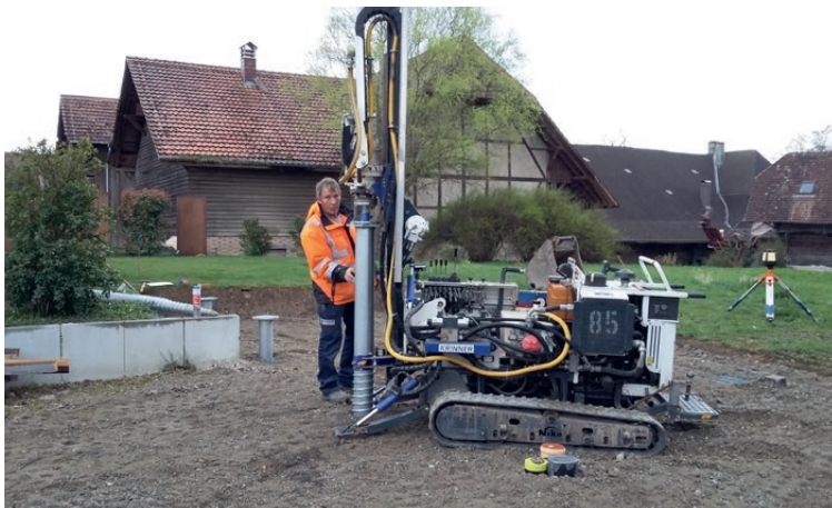
Einbau Schraubfundamente in Ried FR
