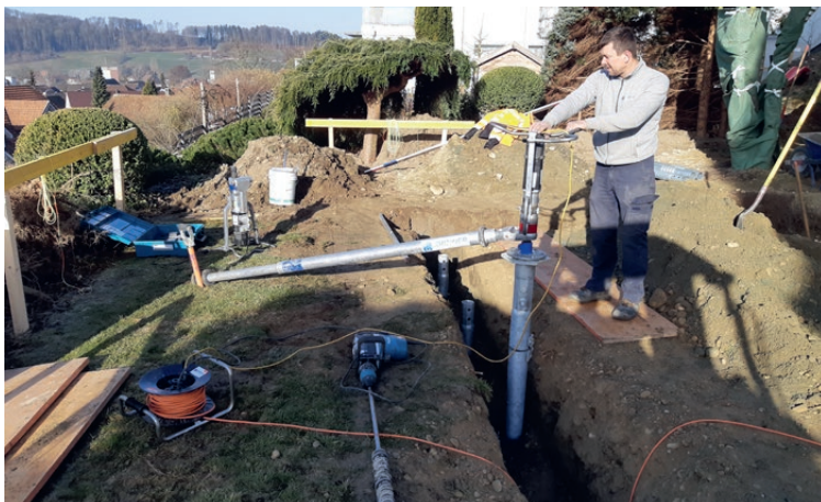
Fundamentbau in Aufschüttung für Wintergarten in Madiswil
