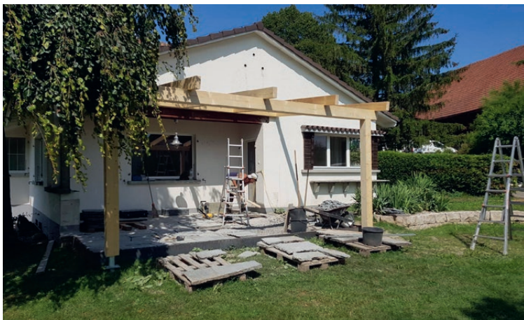
Pergola mit eingespannten Holzstützen Sutz BE
